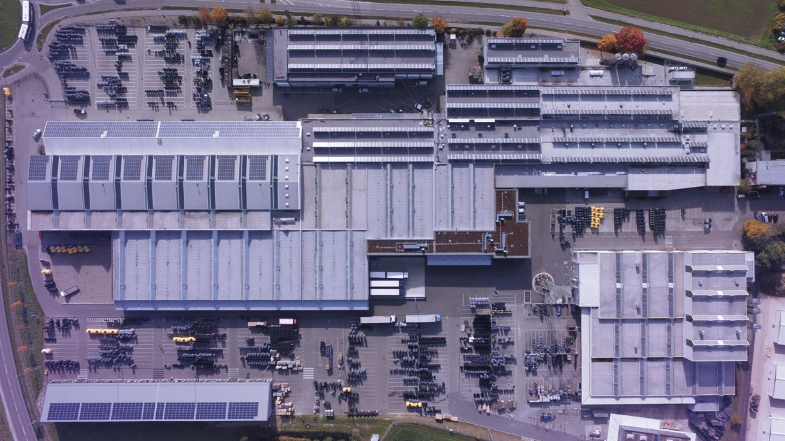
KESSEL Werksgelände, Lenting
